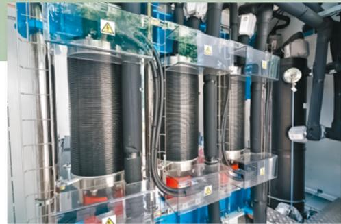
Stacks der PEM-Elektrolyse
